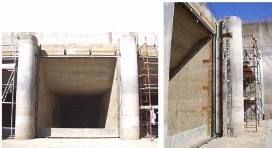
Edificio de Toma de Agua de Refrigeración Principal (UPC) – Sistema PAA 10/20/30 BT001 Montaje de guías marcos para el conjunto de rejas extraíbles, las cuales cumplirán la función del primer filtrado del agua al ingresar al edificio.
