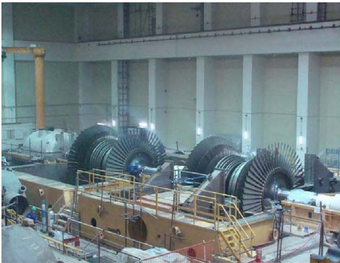
Edificio de máquinas (UMA) – Montaje de los rotores de las turbinas de baja presión
