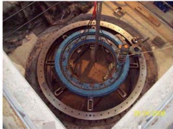
Edificio de Toma de Agua de Refrigeración Principal (UPC) – Maquinado de las bases de las bombas PAC
