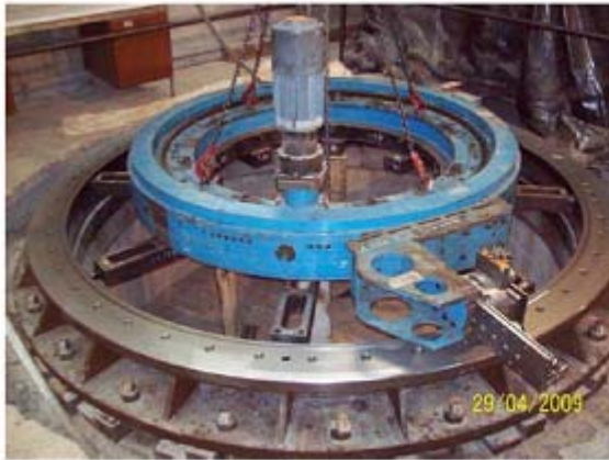
Edificio de Toma de Agua de Refrigeración Principal (UPC) – Maquinado de las bases de las bombas PAC
